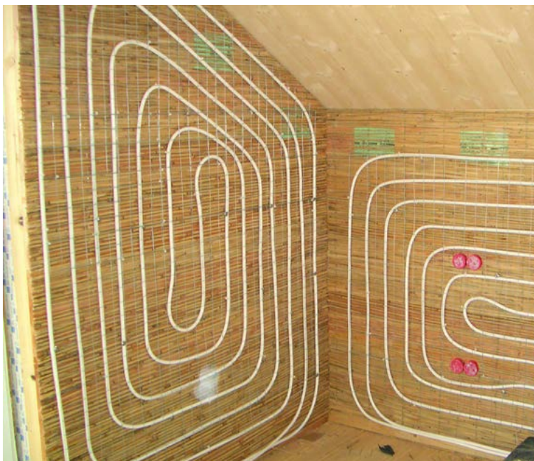
Tubo de cobre aislado para calefacción por pared radiante en la reforma de una buhardilla
